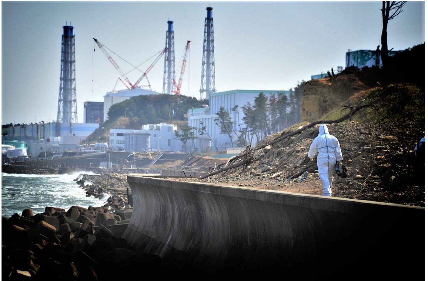
▲前方は福島第一原子力発電所 2013年
